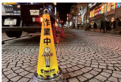
中 建設道路工事
