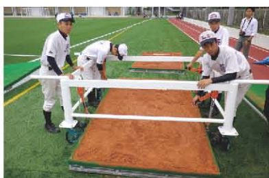
1. レバーブロックで中央部パーツを吊る。
