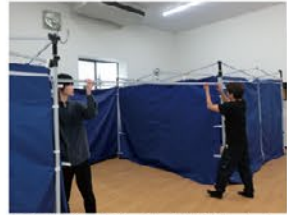
2棟設置後、補強パイプを接続します
